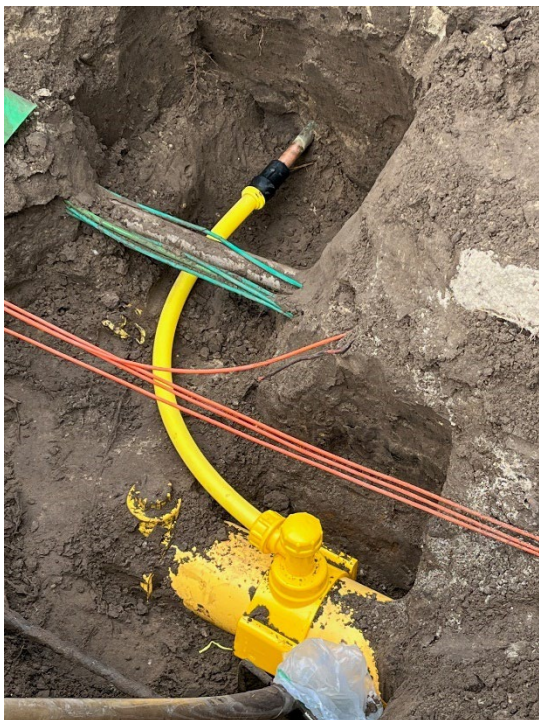
Aansluitleiding vanaf aftakzadel t/m bestaande (koperen) aansluitleiding richting woning.
