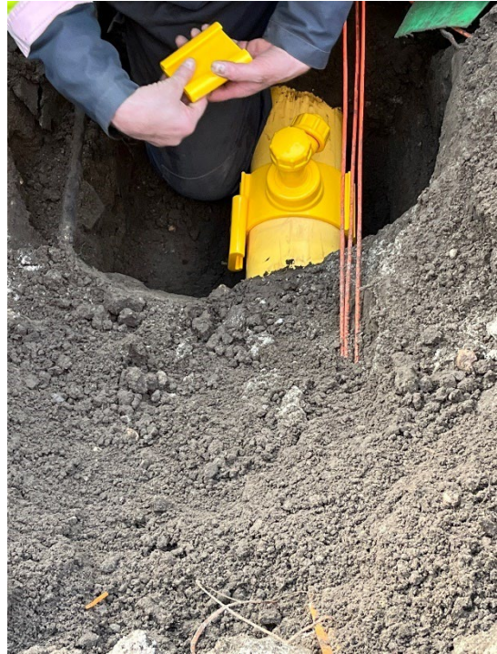
Plaatsen nieuw aftakzadel op H 2 -hoofdleiding.
