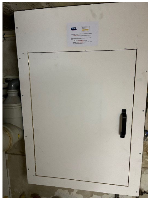
Houtenkastje gasmeteropstelling met instructiekaart.
