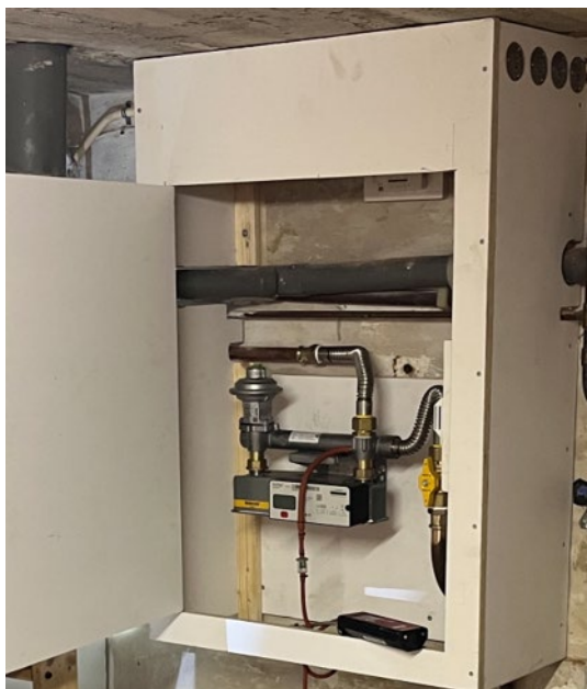
Houtenkastje om gasmeteropstelling heen.
