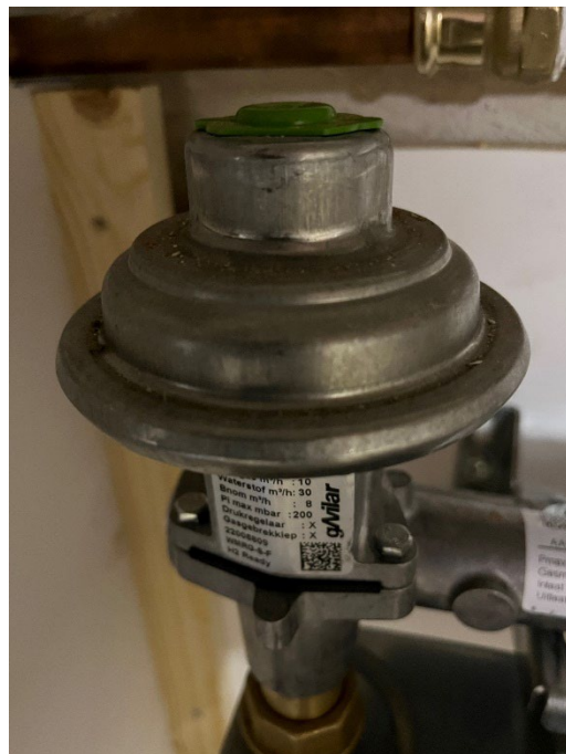
Drukregelaar met gasgebrekbeveiliging.
