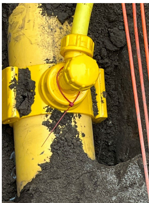
Tiewrap geplaatst om opzetstuk van het aftakzadel.
