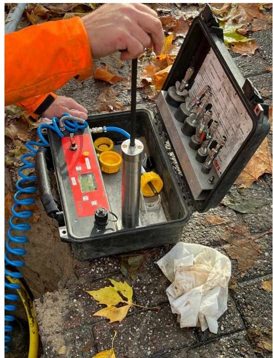
Lekkheidsbeproeving aftakzadel & aansluitleiding tot de hoofdkraan.
