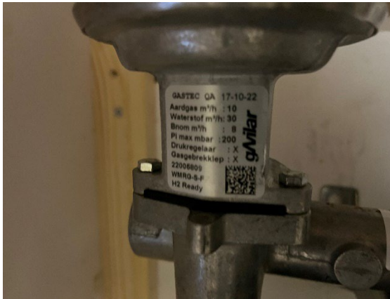
Detailfoto label drukregelaar met gasgebrekbeveiliging.
