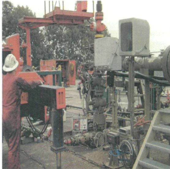
Wireline werkzaamheden t.b.v. het thermogelf project
