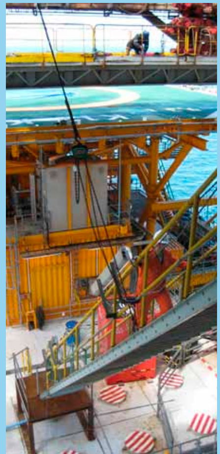
Het puttendeck van de mijnbouwinstallatie gezien vanaf de boorinstallatie (foto SodM)
