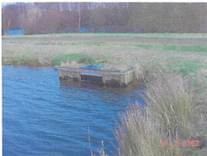
Overlaatconstructie Borgerswold-Langebosch (stuwpeil N.A.P.+0,62m)
