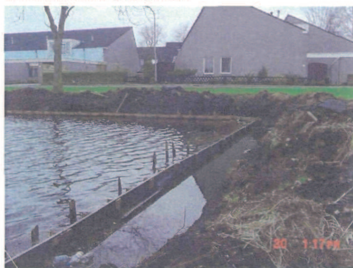
Vervanging van oude beschoeiing (Sorghvliet)
