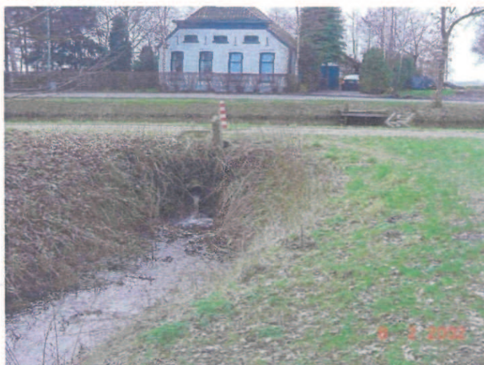
Inlaatduiker Borgerswold-Langebosch westelijke/zuidelijke ringsloot voormalige stortplaats
