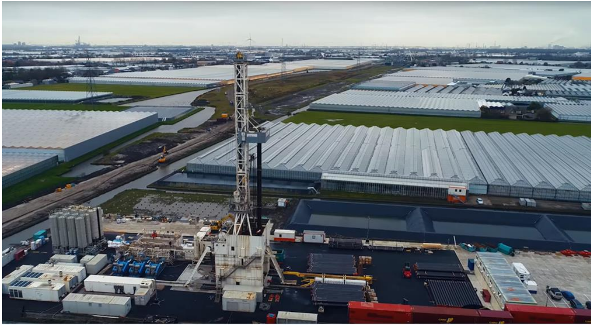
Figuur 2: Mobiele boorinstallatie T-207 van KCA Deutag. Deze installatie is voorzien om te worden gebruikt voor de geplande boringen op de Nedmag locatie WHC-1.
