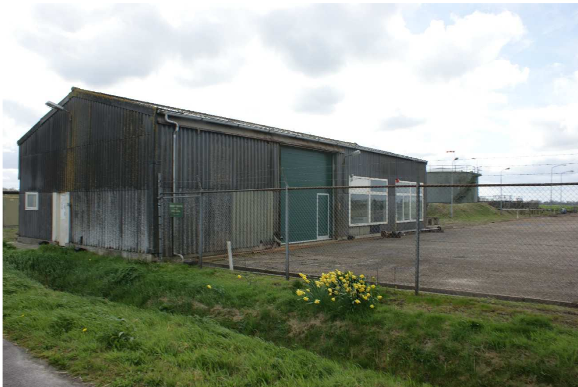
Figuur 2.4 Te slopen loods op bestaande bedrijfslocatie
