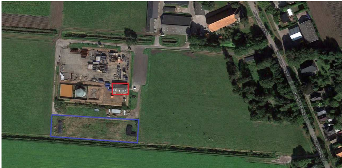
Figuur 2.1 Luchtfoto met huidige situatie (Rood: te slopen loods, blauw: uitbreiding bedrijfslocatie).
