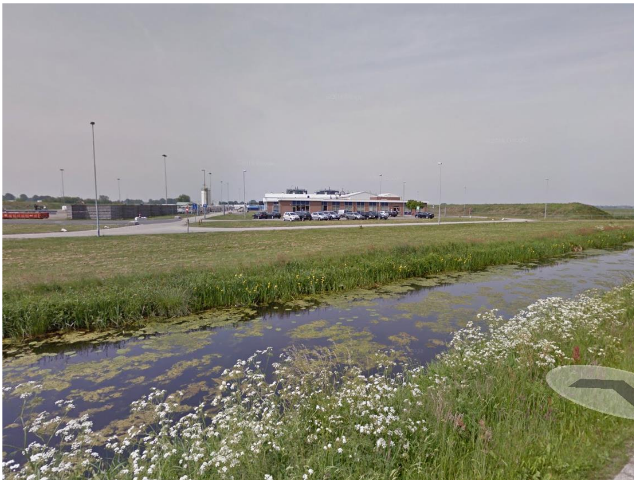
Figuur 4.4: Bestaande situatie locatie WHC-2
