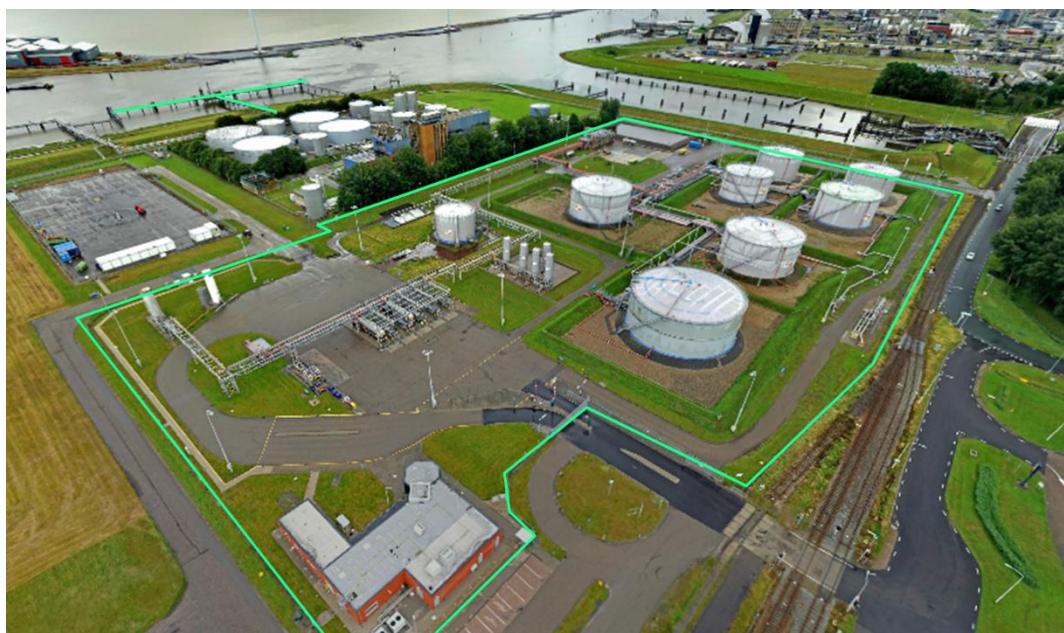
Overzichtsfoto DZLTP met opslag tanks, verlaadplaats en steiger
