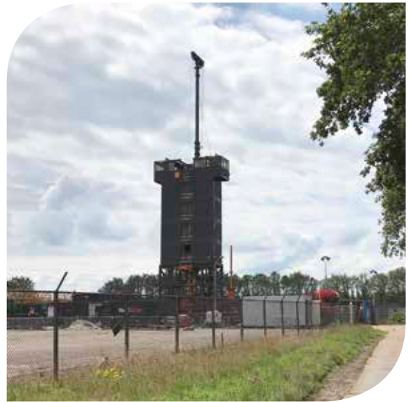
De mobiele opruiminstallatie
