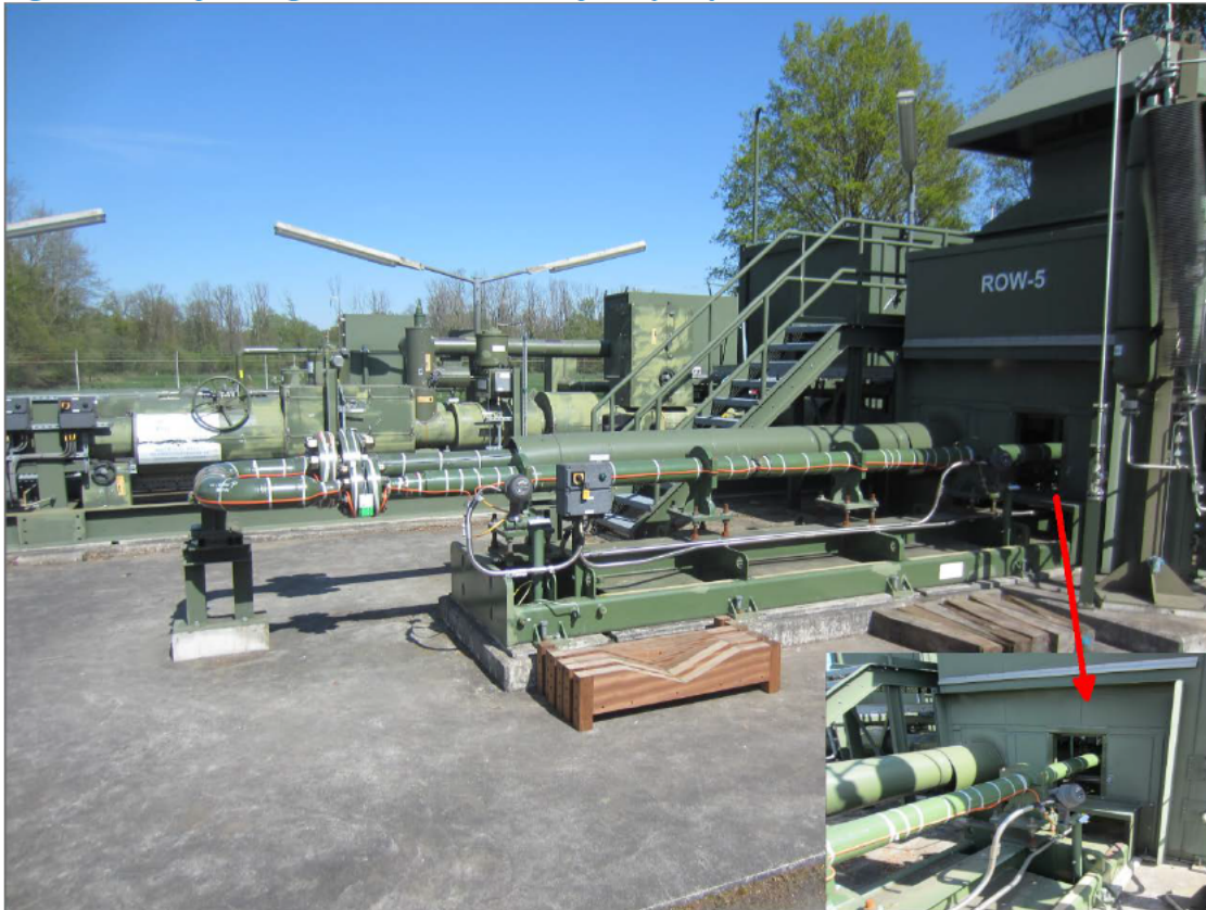
Figuur 1: Verwijderde geluidsisolatie waterinjectiepomp
