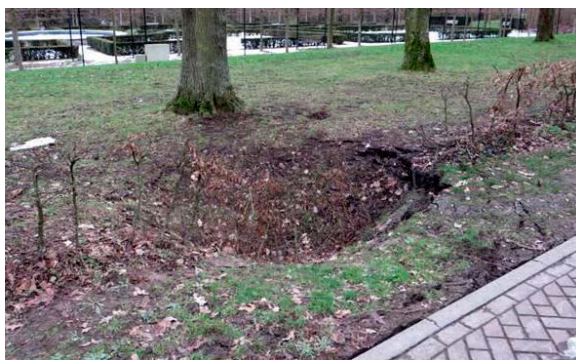
Figuur 34 Eerste tekenen van verzakking in feb 2019 (foto gemeente Kerkrade).
