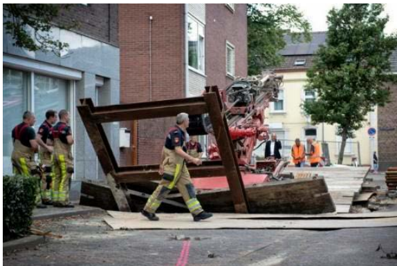
Figuur 19 Breuk van het veiligheidsplatform door het gewicht van de boormachine (Bron: De Limburger, Bas Quaadvlieg).
