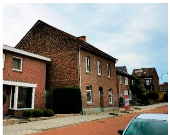
Figuur 9 Woning Bosweg afgebroken en herbouwd.
