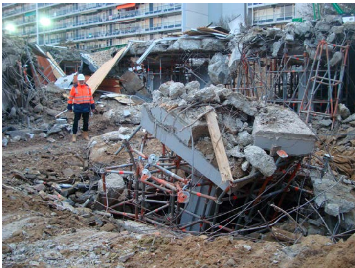
Figuur 27 Sloop van gedeelte van het winkelcentrum 't Loon, 12 december 2011.
