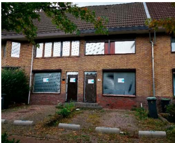
Figuur 8 Aantal woningen Gulikstraat ontruimd.
