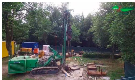
Figuur 38 Boorinstallatie voor saneren van de verzakking bij de kasteeltuin Erenstein (bron: omroep Landgraaf).
