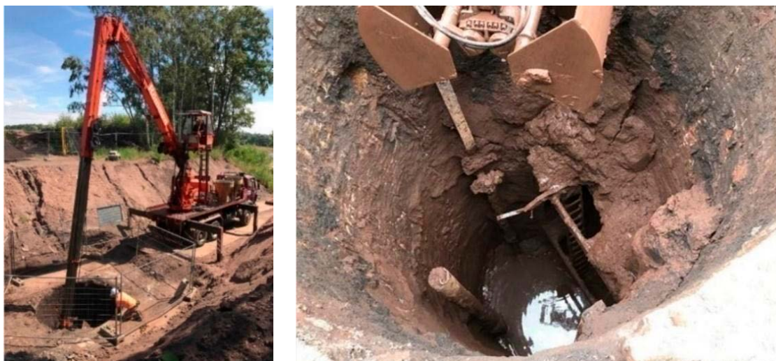
Figuur 21 Uitgraven schacht Melanie (foto's Gemeente Kerkrade).
