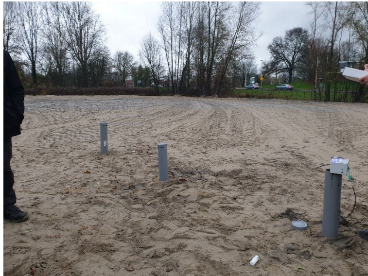
Figuur 57: Drie nieuwe peilbuizen Dwarsdijk West
