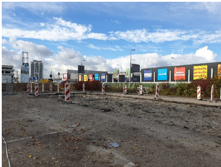
Figuur 45: Asfalt verwijderd. Drie peilbuizen op de voorgrond
